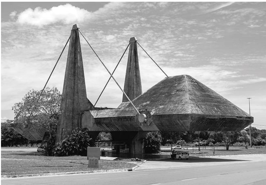
Courtesy Fran Parente João Filgueiras Lima, (Lelé), Centro de Exposições do Centro Administrativo da Bahia, Bahia, Brazil, 1974
